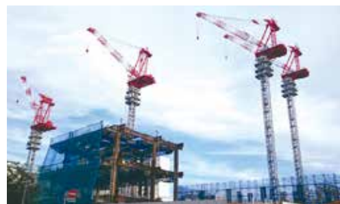
▲工事が進む武蔵小金井駅南口第二地区再開発
